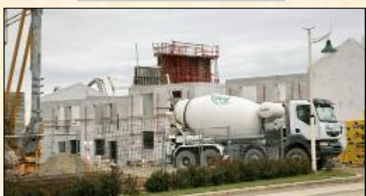
Vues du chantier
